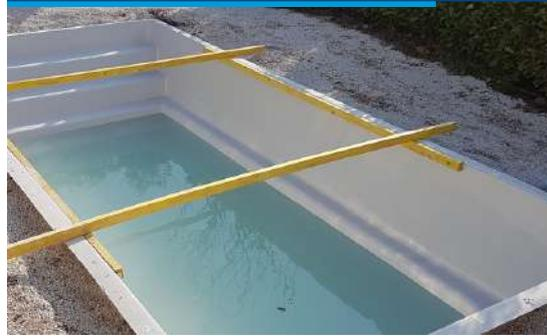
Perçage lèvre et raccordement au ferrailage
