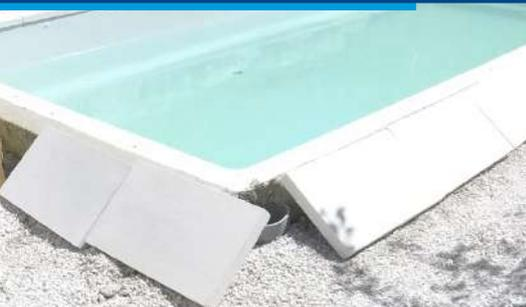
Pose des margelles en s'alignant sur les cordeaux en place
