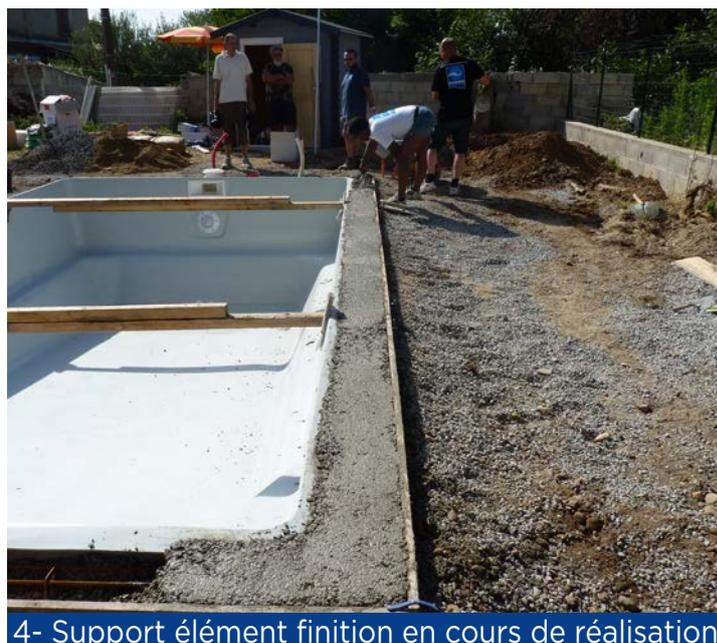
4- Support élément finition en cours de réalisation
